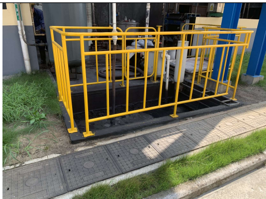
马弗炉车间地下收集池
