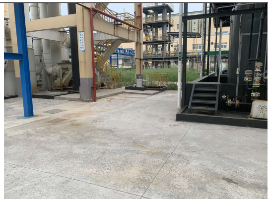
亚钠车间地下收集池
