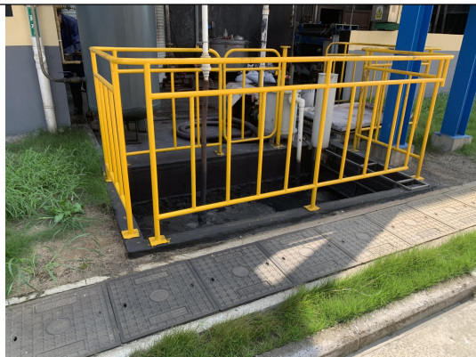
马弗炉车间地下收集池
