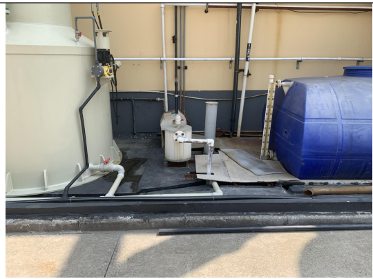
电解车间地下收集池
