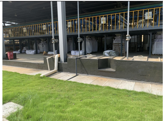
污水站地下收集池
