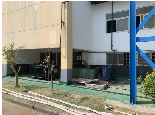
湿法车间地下收集池
